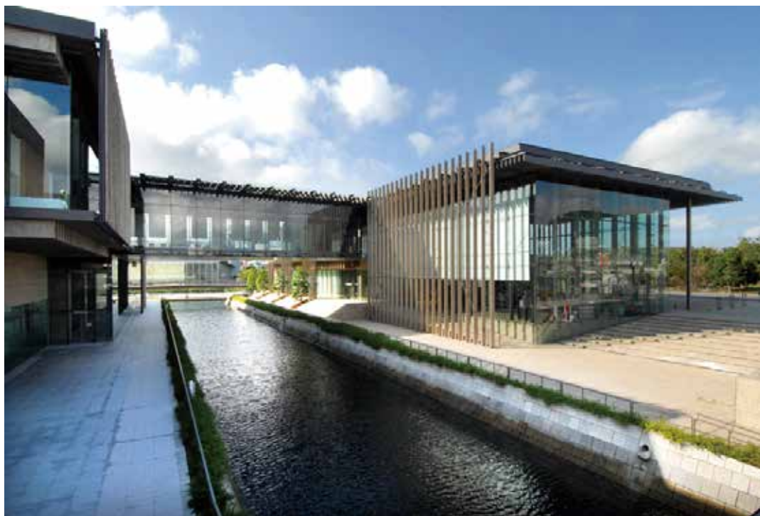
長崎県美術館建物外観
