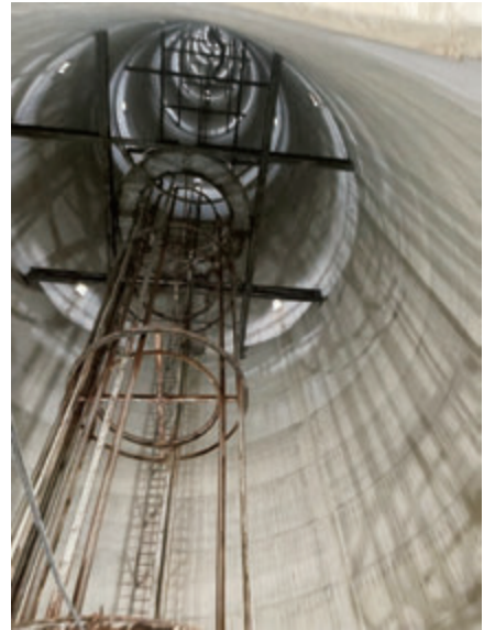
無線塔内部の様子 筆者撮影
