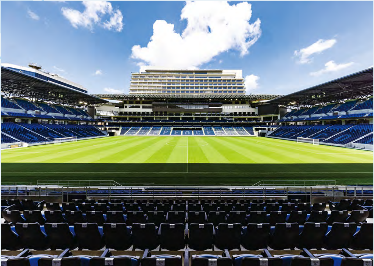
PEACE STADIUM Connected by SoftBank 外観 (提供：長崎スタジアムシティ)
